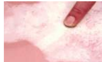
Efecto del depósito de cal en suelos no tratados
