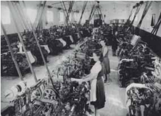
Fábrica RECASENS. La Pobla de Montornès (1922). RECASENS factory. La Pobla de Montornès (1922).
